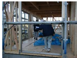
建方・中間検査
